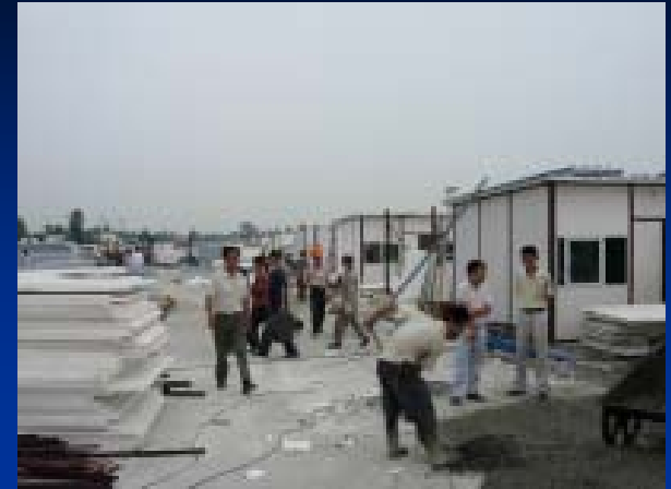
【建設中の仮設住宅(都江堰市)】
