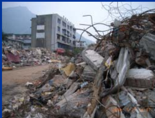
【漢旺鎮の被害状況】
