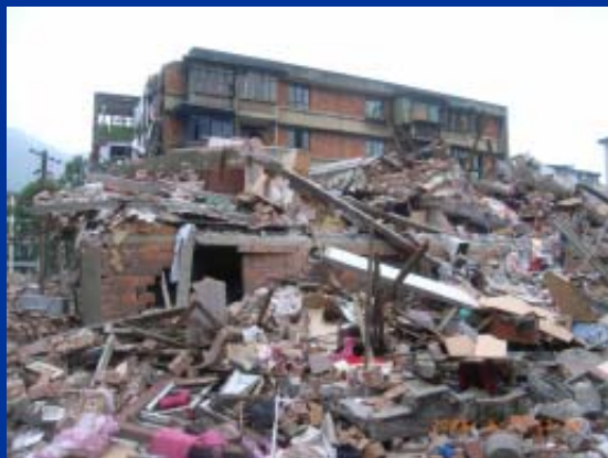
【漢旺鎮の被害状況】
