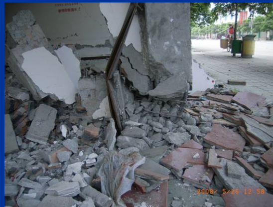
【座屈した鉄筋コンクリート柱】
