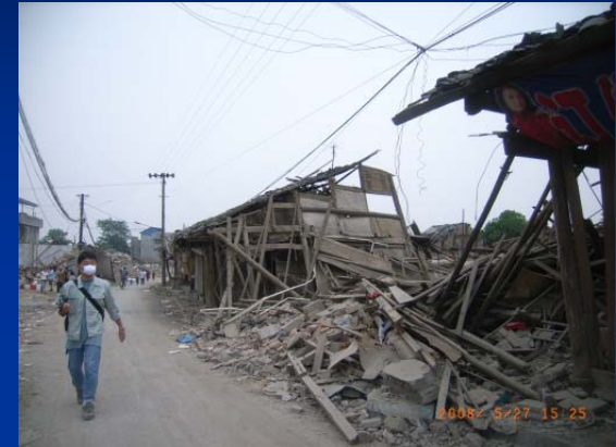
【古い住宅が倒壊】
